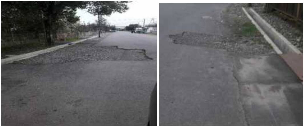
სურათი № 6. რუსთაველის ქუჩაზე დაზიანებული გზის საფარი
