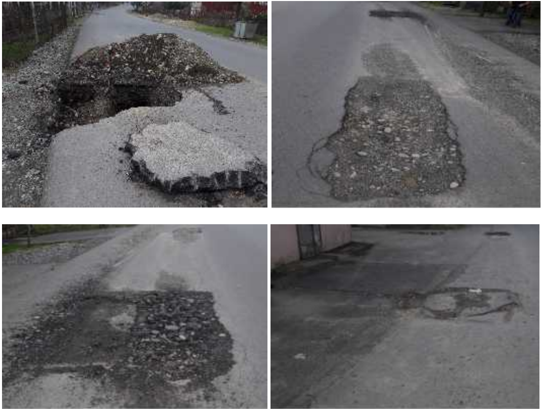
სურათი № 6. რუსთაველის ქუჩაზე დაზიანებული გზის საფარი
